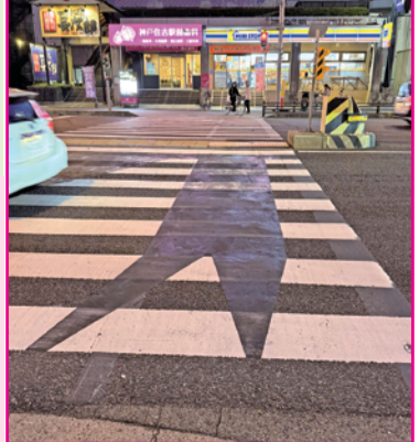
㊴ 横断歩道凹凸補修中の様子(国道2号線住吉交差点)
