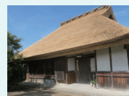
葺き替え後の茅葺民家
