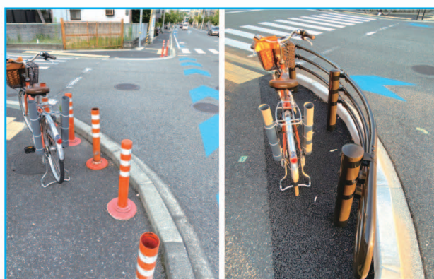
⑲ 車両防止柵(設置前) → (設置後)
