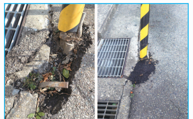
⑲ 魚崎小学校南側の通学路(補修前) → (補修後)
