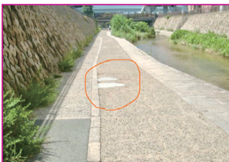
⑲ 路面補修
