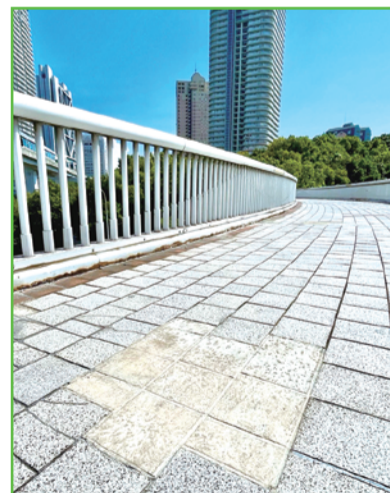
⑰-③ 路面タイル補修
